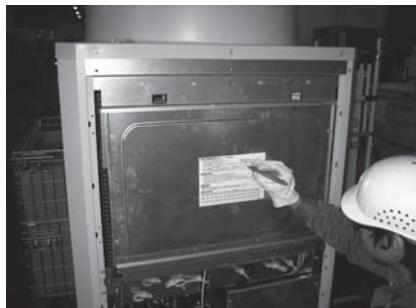
**⑩ Chiusura della valvola nell'apertura di collegamento al circuito di refrigerazione**
